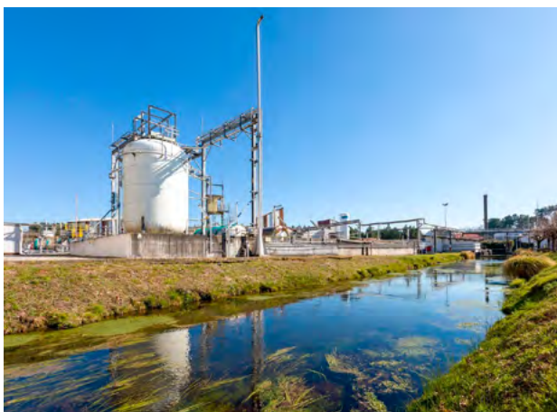
Entreprise MLPC internationale - Lesgor
