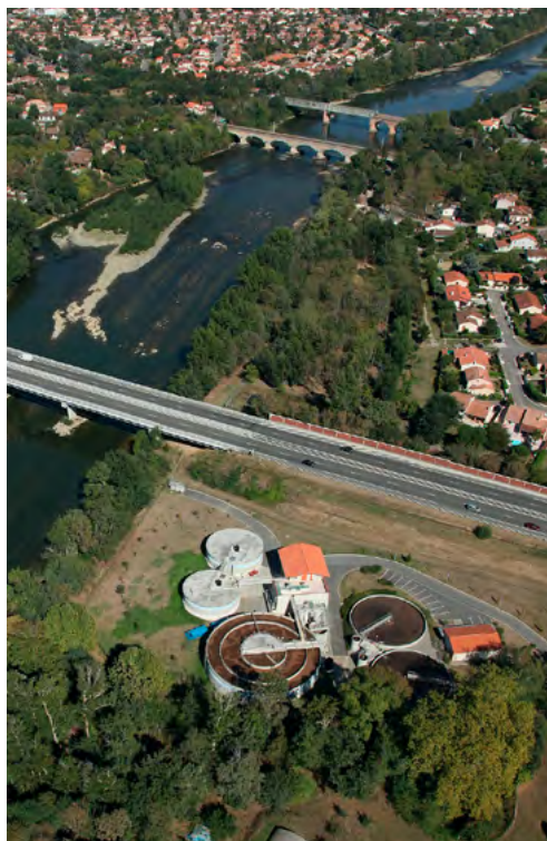
Vue aérienne de la station d'épuration de Pinsaguel en rive droite de la Garonne (31)
