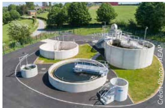
Station d'épuration après travaux à Sémeries, Nord
