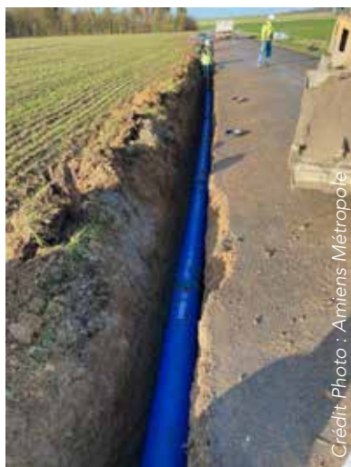
Photos des travaux de résorption des fuites du réseau d'eau potable par Amiens Métropole
