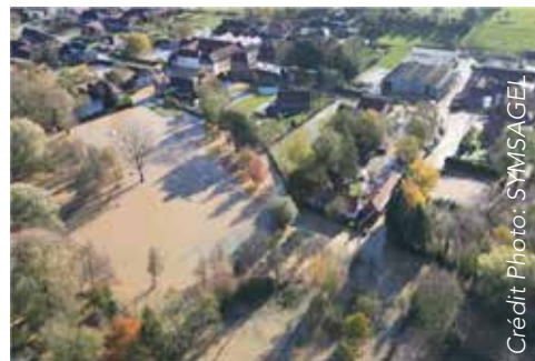
Inondations dans le bassin Artois-Picardie (commune de Delettes)
