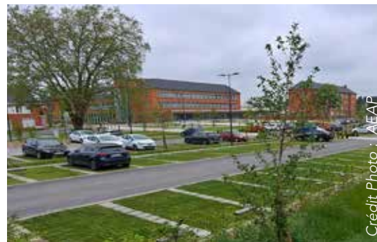
Infiltration des eaux pluviales, parking de Douai
