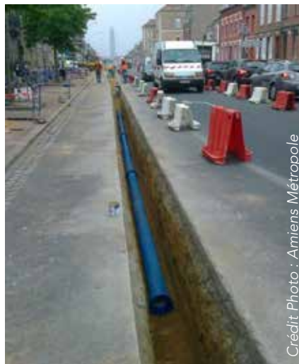
Photos des travaux de résorption des fuites du réseau d'eau potable par Amiens Métropole
