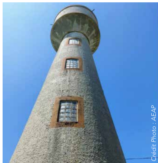
Réhabilitation d'un réservoir de stockage dans la commune de Pénin, Pas-de-Calais
