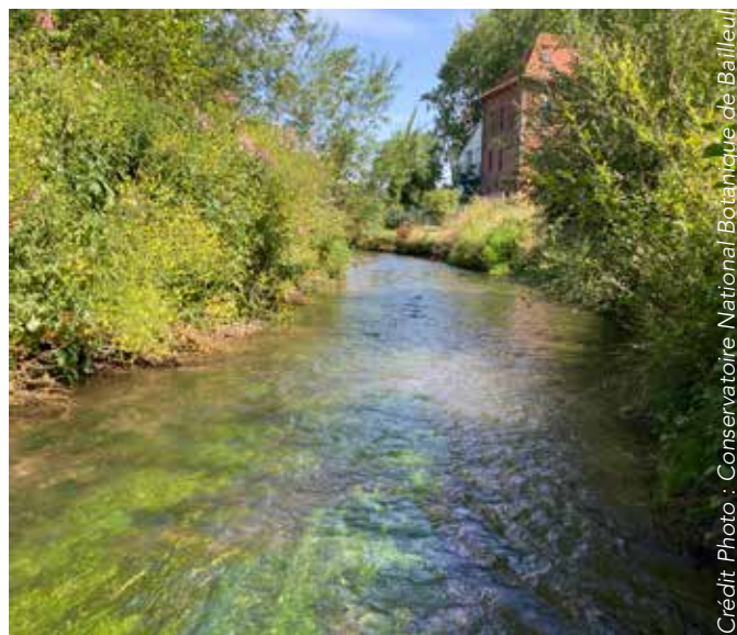
Suivi de l'efficacité des travaux de rétablissement de la continuité écologique de la Hem, photo en amont de l'ancien seuil du Moulin de Leulenne
