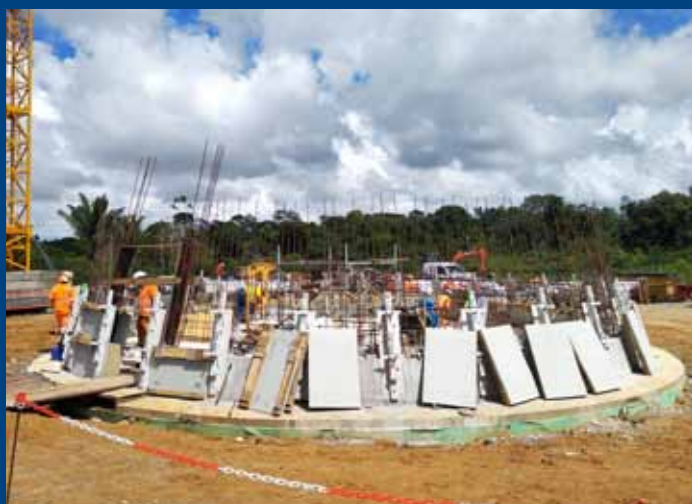
Réservoir Paul Castaing, déc. 2020 © Antoine BAJEUX, EGIS
