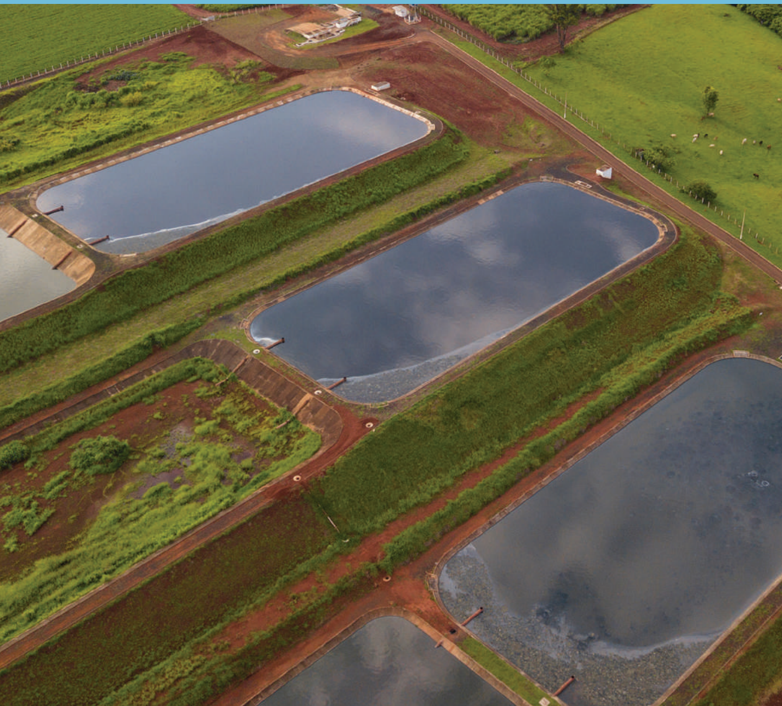
Vue aérienne du traitement des eaux usées.
