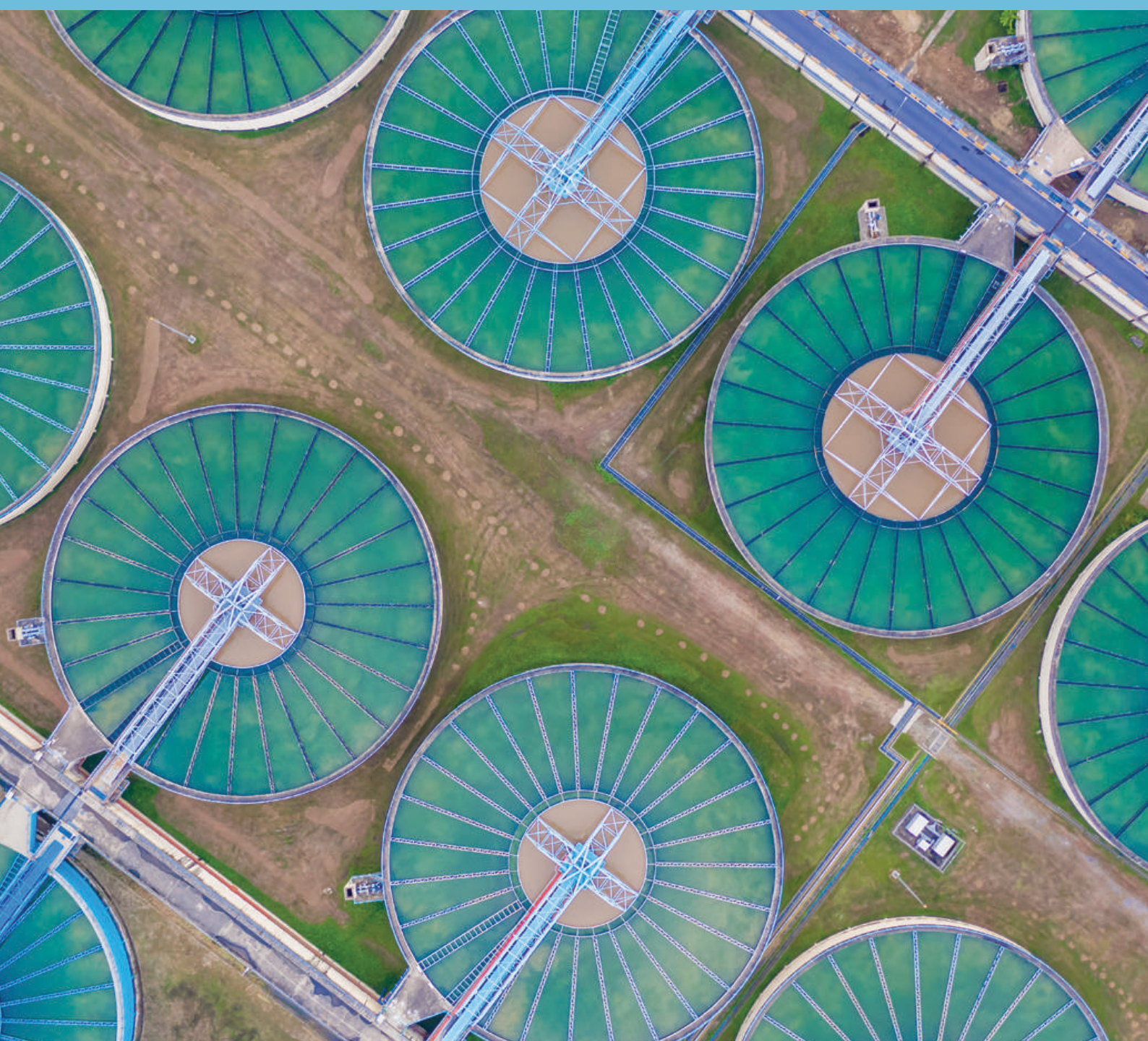
Vue aérienne d'une station d'épuration.
