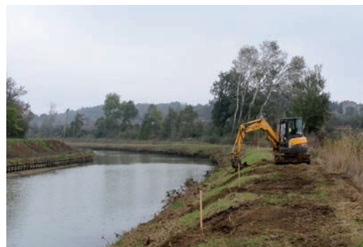
Travaux sur berge à proximité de l'écluse de Villedubert Arnaud Bouissou/MEDDE
