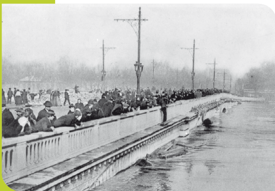
↘ La crue de 1910 au pont de Tolbiac.
