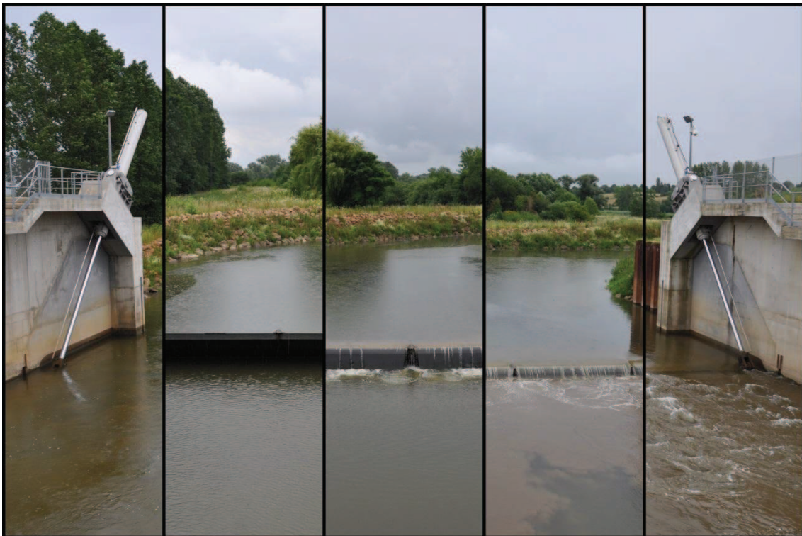
Figure 69. Fonctionnement du clapet mobile (Proisy)
