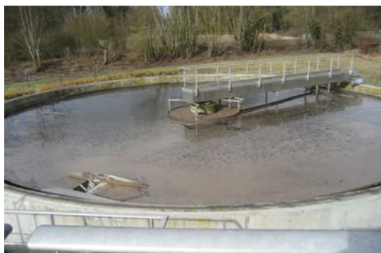
Clarificateur : Voulx (à gauche) et Nemours (à droite)
